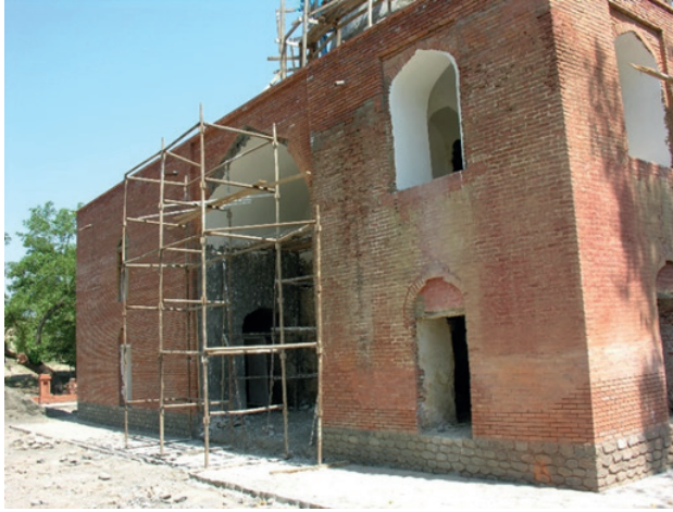
Resim 2. Kusar-Hazra Köyü (Azerbaycan), Şeyh Cüneyd Türbesi. Restorasyon sonrası güneybatıdan genel görünüş (2006).
