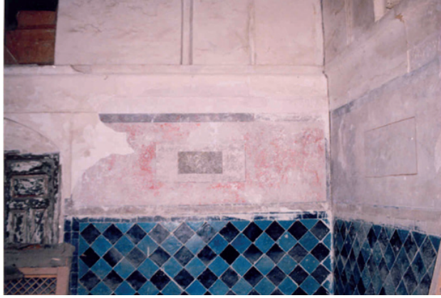
Resim 17. Kusar-Hazra Köyü, Şeyh Cüneyd Türbesi: Ziyaret mekânı güney duvarının batı kanadındaki kalem işi süslemelerin restorasyon öncesi görünüşü (2003).
