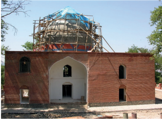
Resim 10. Kusar-Hazra Köyü, Şeyh Cüneyd Türbesi: Doğu eyvanın kemer köşeliğindeki sırlı tuğla süslemelerin restorasyon sonrası görünümü (2006).
