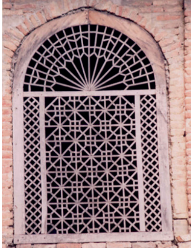
Resim 19. Kusar-Hazra Köyü, Şeyh Cüneyd Türbesi: Güney cephe ikinci kat pencere şebekesi restorasyon öncesi görünüşü (2003).
