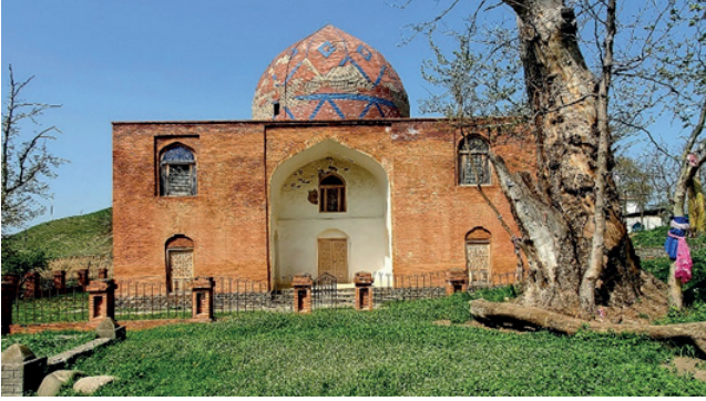
Resim 11. Kusar-Hazra Köyü, Őeyh Cüneyd Türbesi: Kubbe ve kasnađındaki sırlı tuđla süslemelerin restorasyon sonrası görünümü (2021 https://commons.wikimedia.org/wiki/File:%C5%9Eeyx_C%C3%BCneydin_t%C3%BCrb%C9%99si_(13).jpg#/media/File:%C5%9Eeyx_C%C3%BCneydin_t%C3%BCrb%C9%99si_(13).jpg ).
