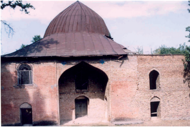
Resim 8. Kusar-Hazra Köyü, Şeyh Cüneyd Türbesi: Doğu eyvanın ve sırlı tuğla süslemelerin restorasyon öncesi görünüşü (2003).
