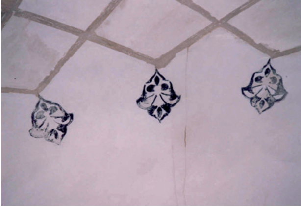
Resim 16. Kusar-Hazra Köyü, Şeyh Cüneyd Türbesi: Kubbe içi kalem işi süslemelerden ayrıntı (2003).
