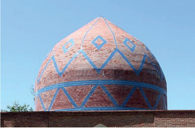
Resim 7. Kusar-Hazra Köyü, Şeyh Cüneyd Türbesi: Kubbe kasağındaki sırlı tuğla süsleme kuşağının restorasyon sonrası görünümü (2007).
