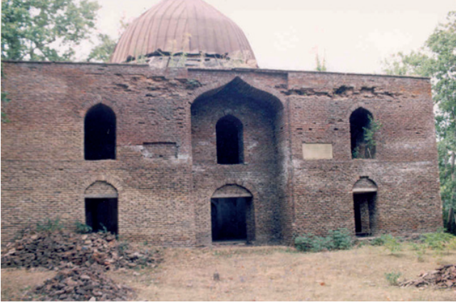
Resim 3. Kuzar-Hazra Köyü (Azerbaycan), Şeyh Cüneyd Türbesi. İnşa kitabesinin yeraldığı kuzey cepheden görünüş (2003).
