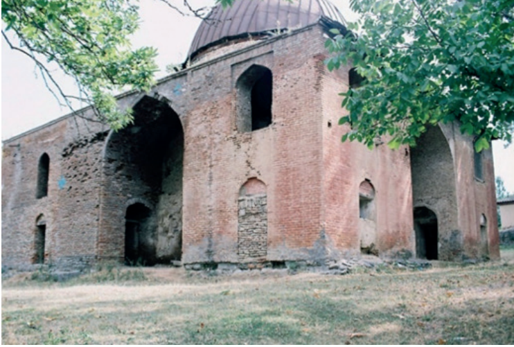
Resim 1. Kusar-Hazra Köyü (Azerbaycan), Şeyh Cüneyd Türbesi. Restorasyon öncesi güneybatıdan genel görünüş (2003).
