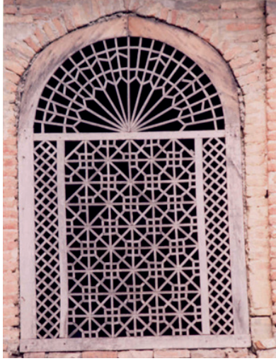
Resim 19. Kusar-Hazra Köyü, Şeyh Cüneyd Türbesi: Güney cephe ikinci kat pencere şebekesi restorasyon öncesi görünüşü (2003).
