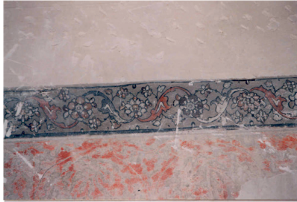
Resim 18. Kusar-Hazra Köyü, Şeyh Cüneyd Türbesi: Ziyaret mekânı güney duvarının batı kanadındaki kalem işi süslemelerden bir bölümünün restorasyon öncesi görünüşü (2003).
