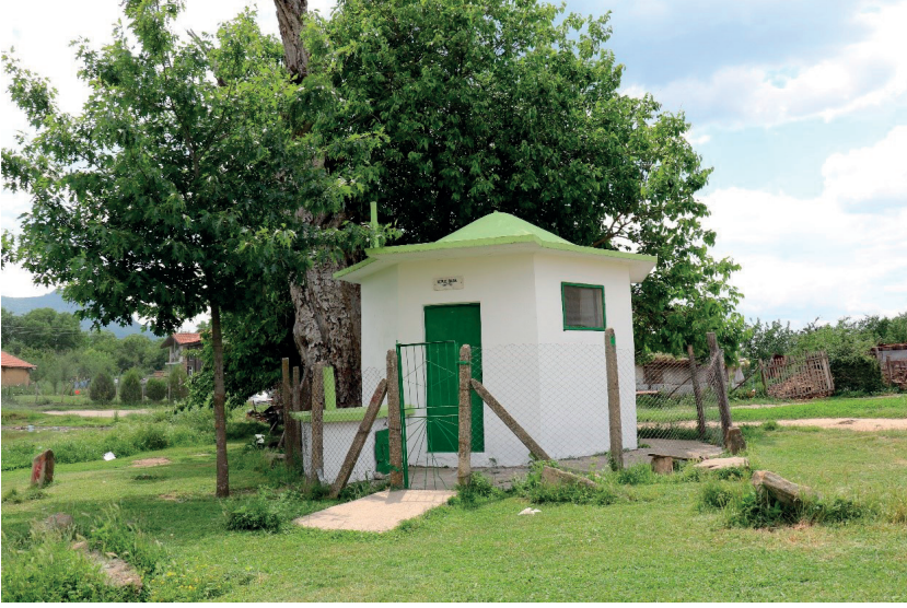
Alvanlar Köyü Topuz Baba Türbesi
